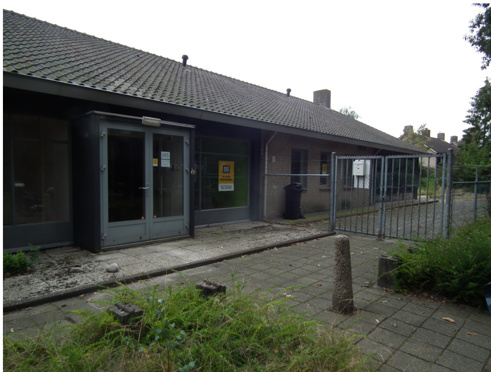
Figuur 3 Men is voornemens het kinderdagverblijf te slopen en er een vrijstaande woning en twee-onder-een-kap woningen te realiseren.
