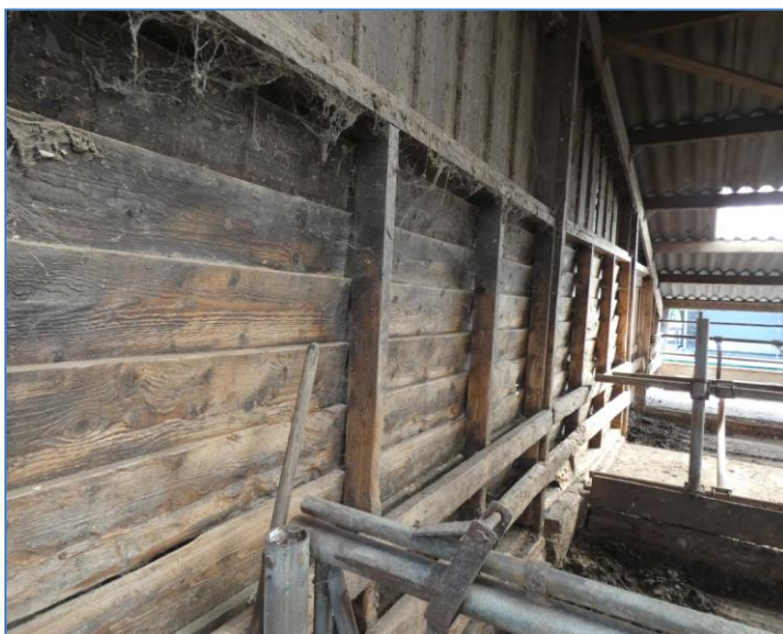
Foto 14 kopgevel (noord) gebouw 1 met enkele hout-beplating als wand
