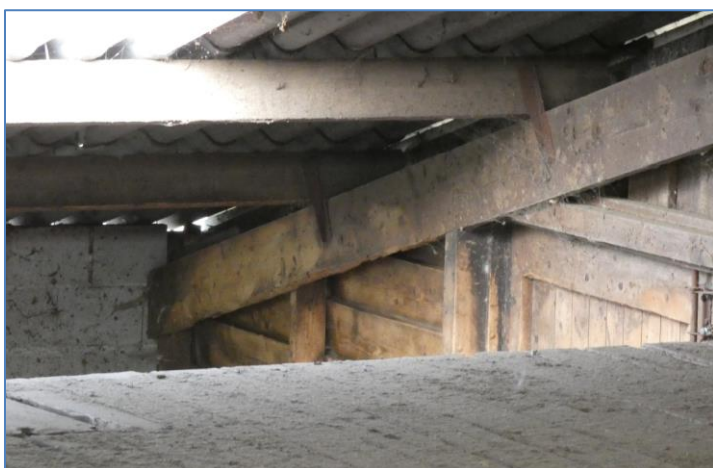
Foto 15 dak en gevel gebouw 1 met enkele constructie
