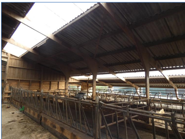
Foto 16 kopgevel en dak gebouw 1 breder beeld enkele 'beplatingsconstructie
