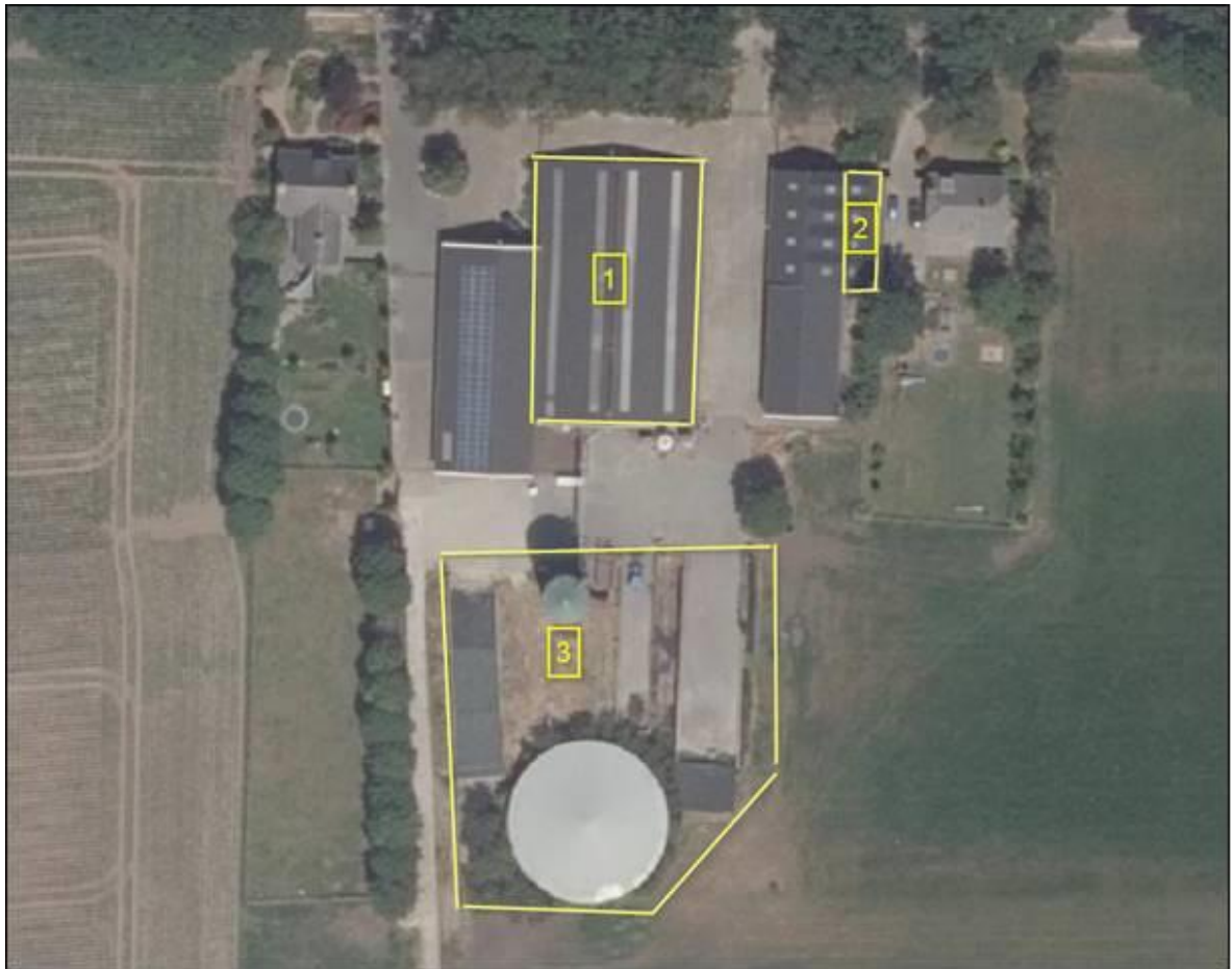
Figuur 2 Luchtfoto huidige situatie met aanduiding van de te slopen opstallen. De bedrijfslocatie is bebouwd met twee bedrijfswoningen met 4, in deels aan elkaar gebouwde rundveestallen / bedrijfsgebouwen, sleufsilos en een drijfmestsilo. Het voornemen betreft de sloop van de sleufsilos, de drijfmestsilo ( 3) een rundveestal ( 1) en een gedeelte van een andere rundveestal (2) .
