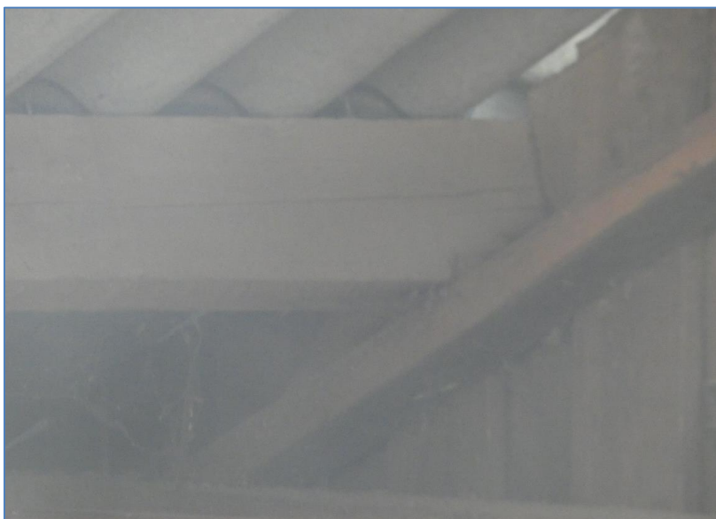
Foto 19 enkelwandig dak (golfplaten) en voorgevel (noord) planlocatie 2
