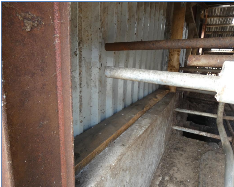
Foto 13 kopgevel (zuid) gebouw 1 met enkele staal-beplating als wand
