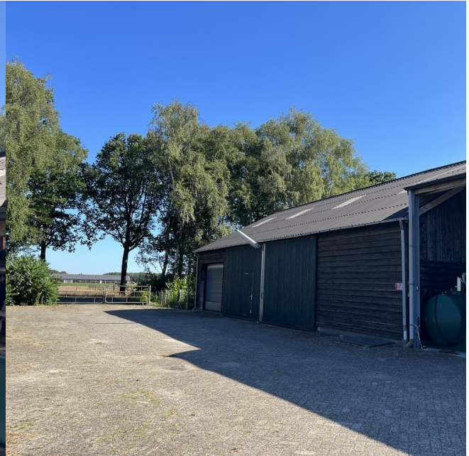
foto 2 loods, voorzien van asbestvrije golfplaten in 2012
