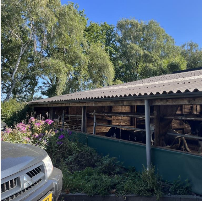
foto 1 stal 1, voorzien van asbestvrije golfplaten in 2012
