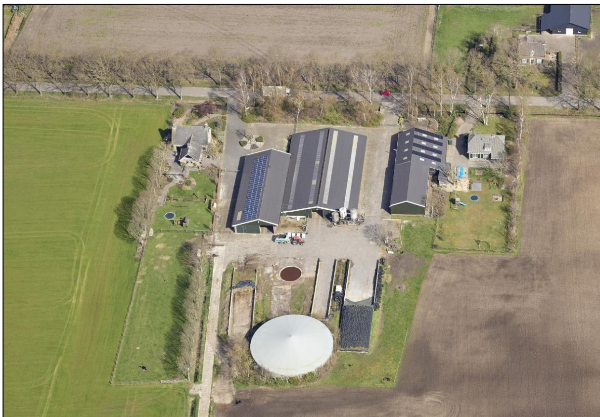
Drone-opname projectlocatie (d.d. maart 2021, noordelijke richting)
