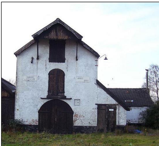
Bebouwing van de opvolger van de windmolen: de maalderij
