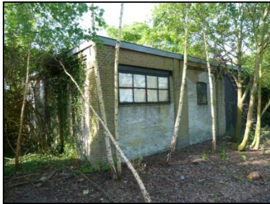
Figuur 6. Te slopen werkschuur.
