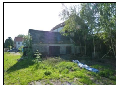
Figuur 5. Achterzijde voormalige maalderij.
