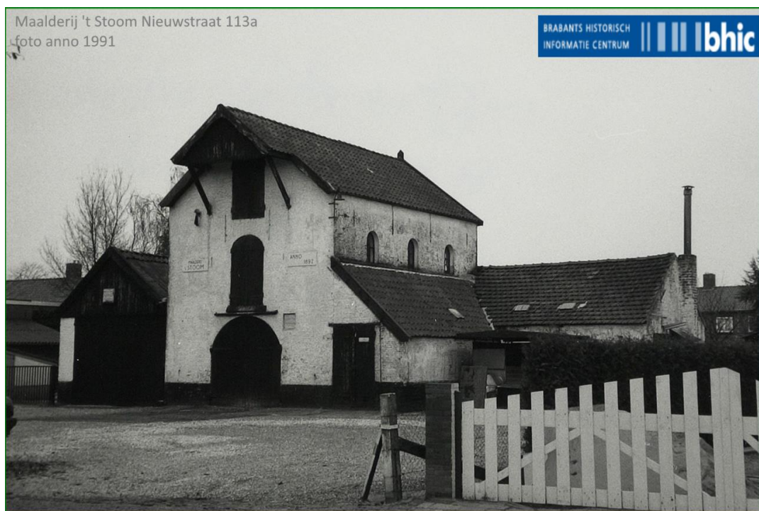
Afbeelding 2.1 Foto vooraanzicht vanaf de Nieuwstraat.
