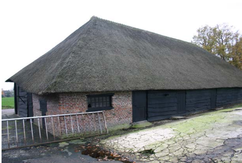
Afbeelding 3. Zicht op de Vlaamse schuur vanuit het noorden.
