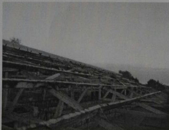
Foto 2 : Hier zijn de golfplaten verwijderd.
