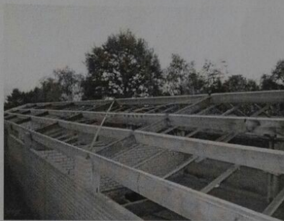
Foto 1 : Hier zijn de golfplaten verwijderd.
