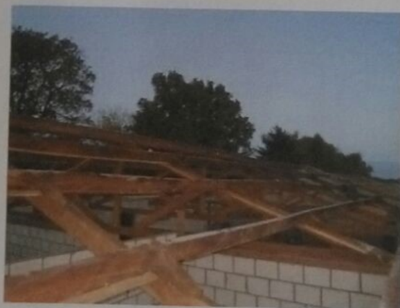
Foto 2 : Hier zijn de golfplaten verwijderd.
