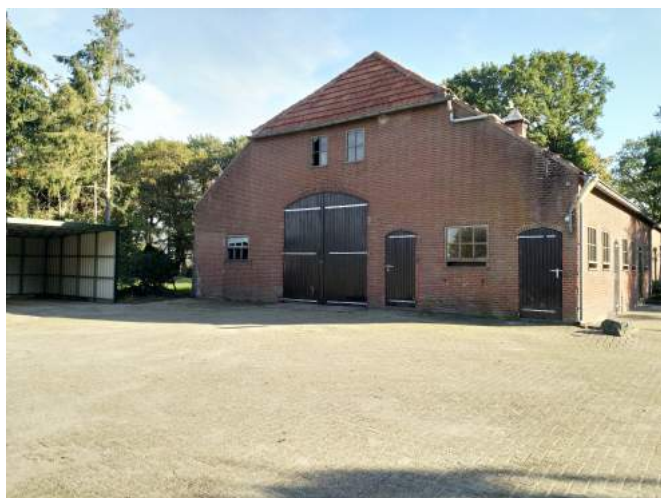
Afbeelding 2. Boerderijschuur waarvan het dak eventueel vervangen wordt.
