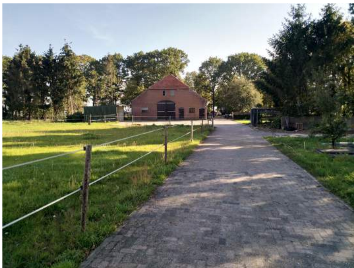
Overzicht plangebied met op de achtergrond de boerderijschuur waarvan het dak mogelijk wordt vervangen.
