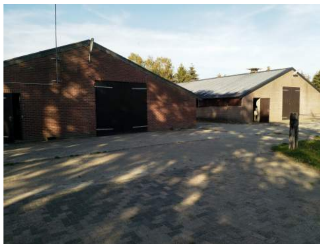
Afbeelding 3. De te slopen pluimveestallen
