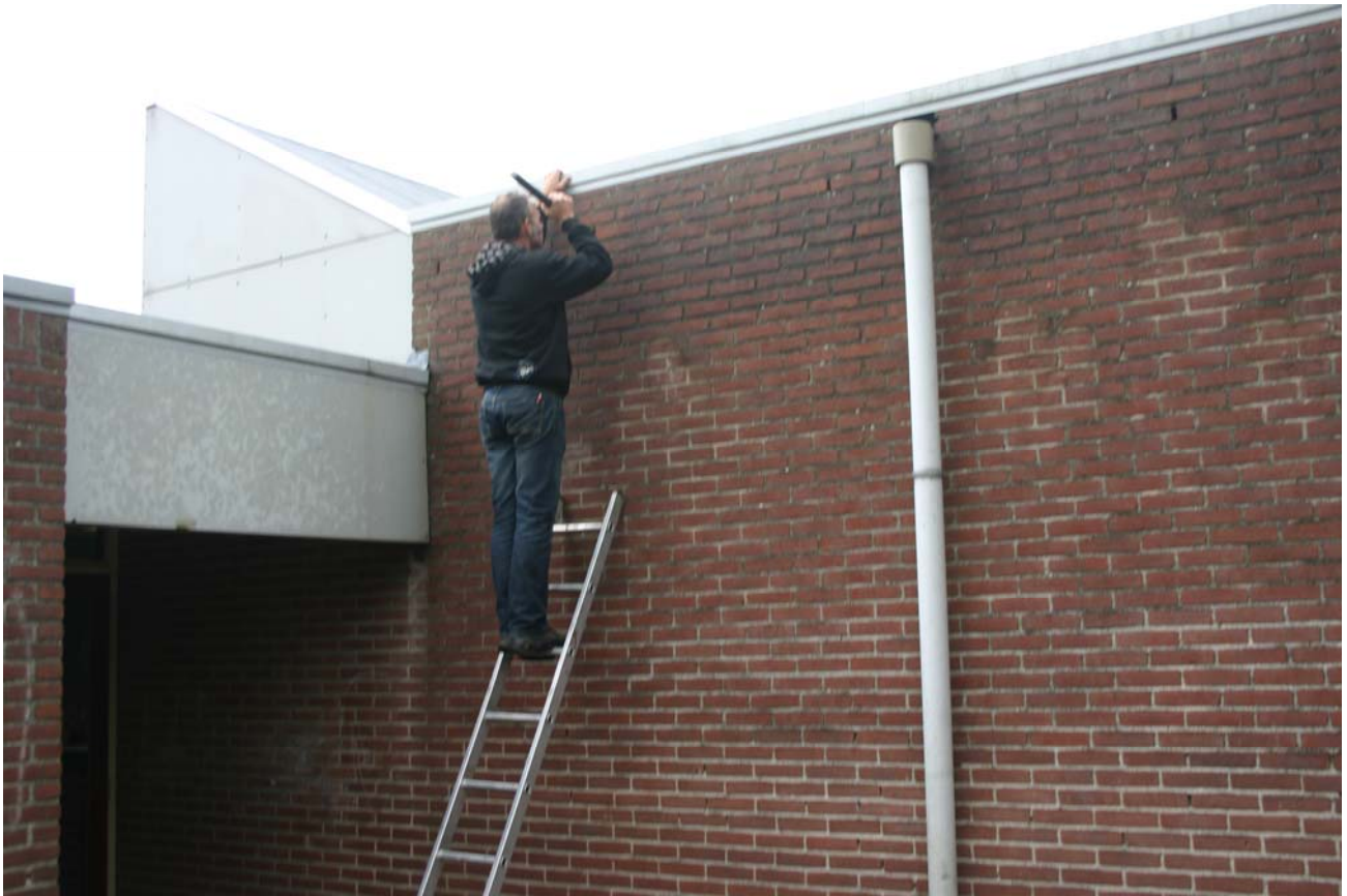
Figuur 6. Alle open stootvoegen werden tijdens het veldbezoek geïnspecteerd met een zaklamp.
