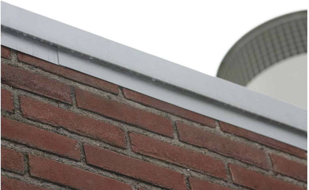
Figuur 7. De dakstrips sluiten overal nauw aan op de onderliggende gevel.
