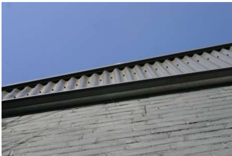
Figuur 4.4.1. In de opgemetselde gevels zijn openingen, waardoor vleermuizen het gebouw binnen kunnen, afwezig. De golfplaten gevelbekleding sluit strak op de gevels aan en is te glad voor vleermuizen; hierop krijgen ze geen grip.
