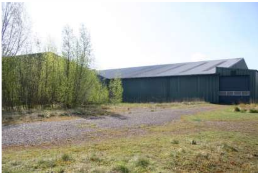
Figuur 4.4.6. Locatie aan de noordwestzijde waar nieuwe magazijnen worden gerealiseerd.
