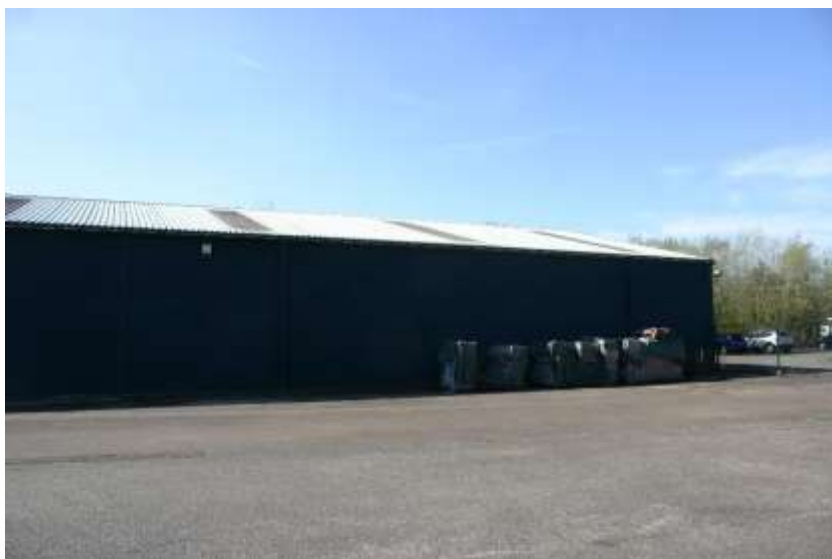
Figuur 4.4.5. Locatie waar de overkapping wordt gerealiseerd.
