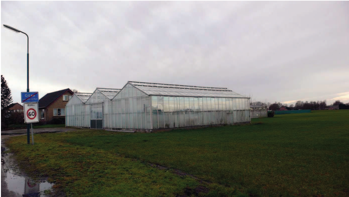
Figuur 9 foto te slopen kas op planlocatie
