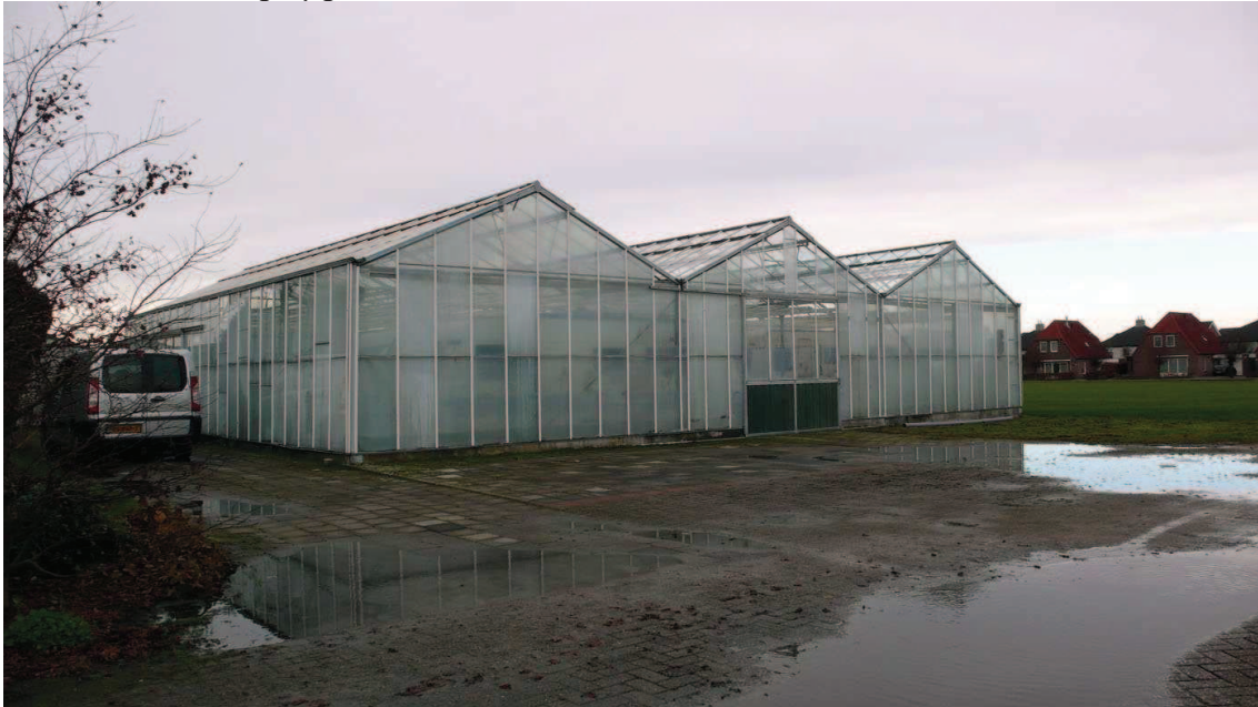
Figuur 8 Te slopen kassen
