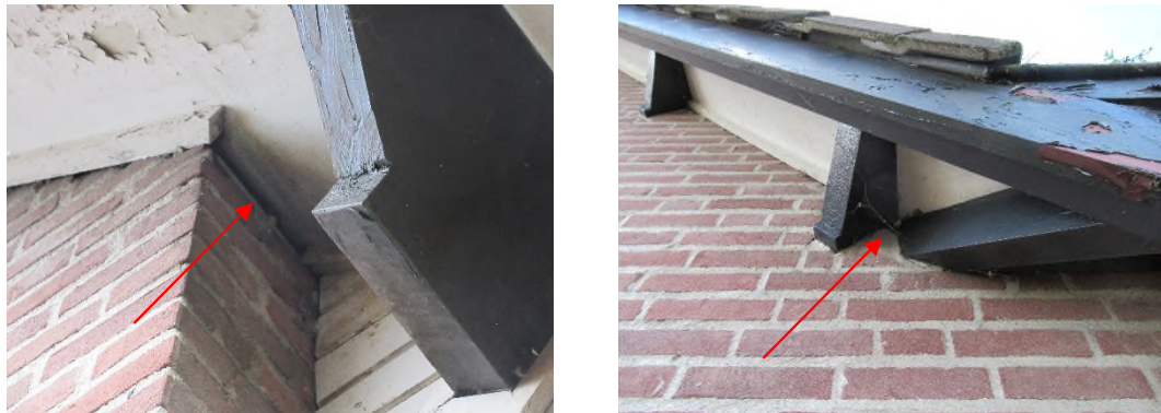
Figuur 4.3. Mogelijk verblijfplaatsen vleermuizen in de woning aan de Mosstraat nr. 6.
