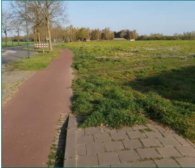
Figuur 8: Kabel- en leidingentracé in fietspad. (foto genomen in westelijke richting)
