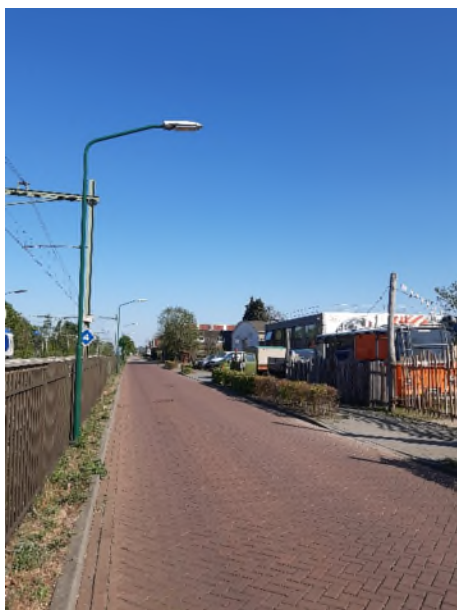
Fotonummer: 43 Omschrijving: overzicht Parallelweg vanaf spoorovergang
