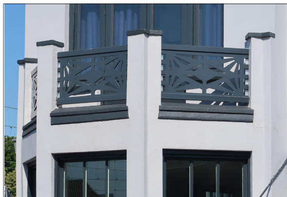
Architectonische articulatie: erker met balkon.
