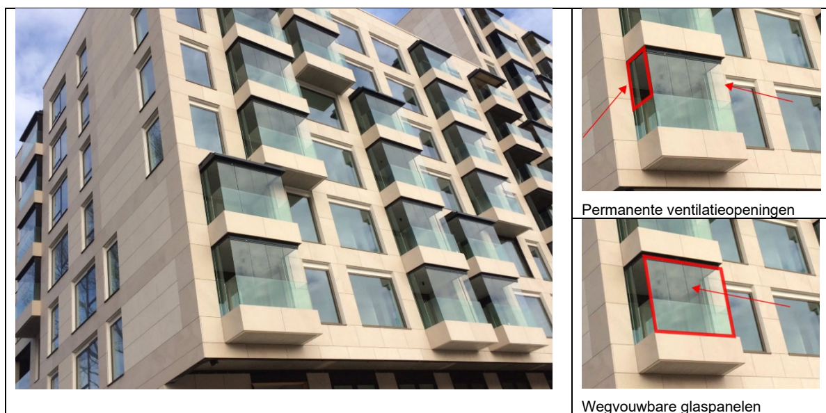
Figuur 6.9: Verglaasde balkons in project DeFred020 in Amsterdam
