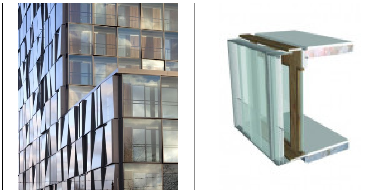
Figuur 6.4: Vliesgevels in project Het Kasteel/Science Park in Amsterdam
