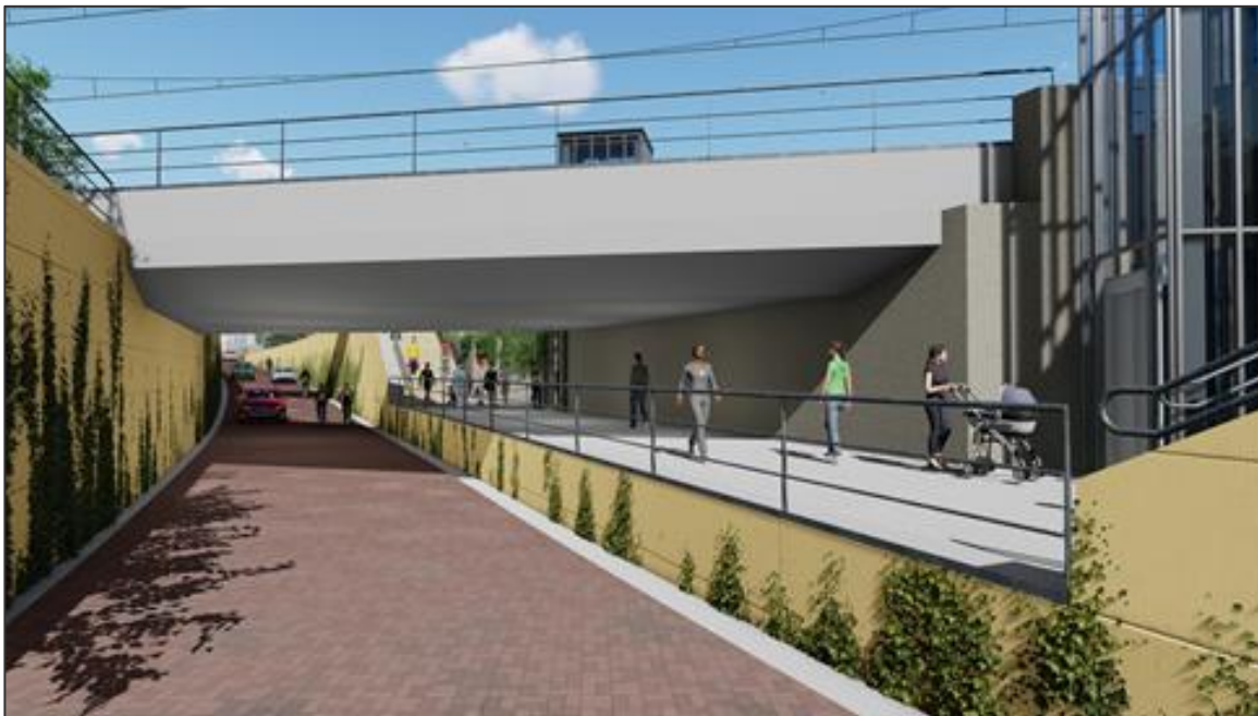
Afbeelding 2.2 Impressie onderdoorgang met rechts het verhoogde voetpad en een liftschacht. In het toekomstige plan betreft het een onderdoorgang welke niet toegankelijk is voor gemotoriseerd verkeer.
