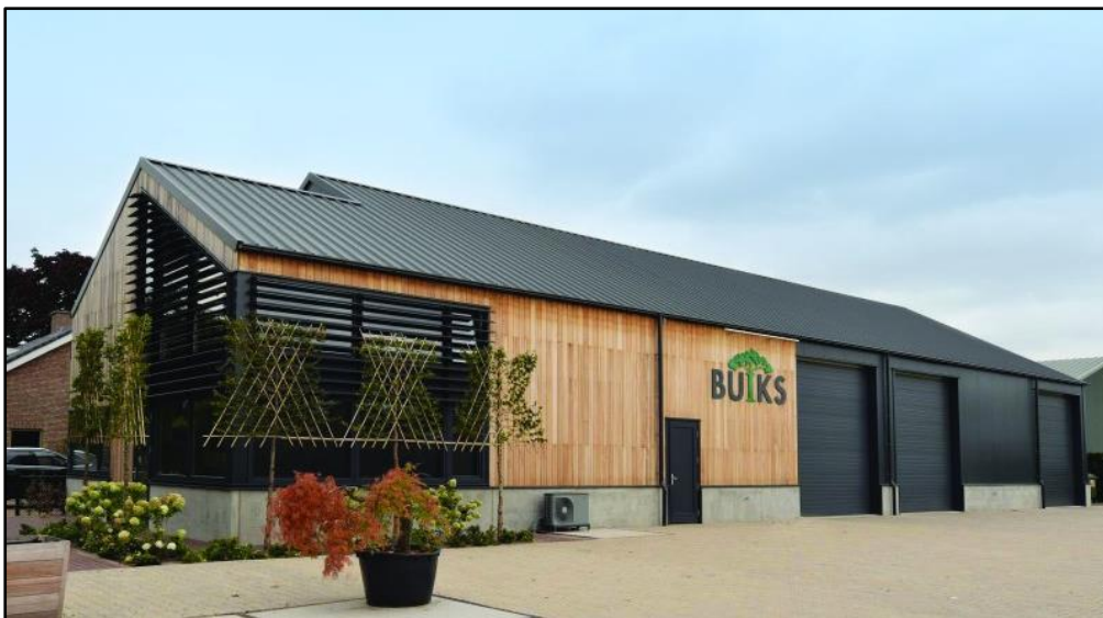
Afbeelding 10: Sfeerbeeld verbouw Loods
