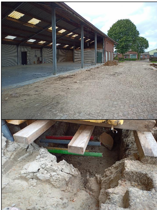
Linksboven: De te behouden kapschuur in het zuidwesten van het plangebied. De ontgraving (linksonder) bevindt zich bij de storthoop die op deze foto te zien is. Rechts de wijze van fundering van deze schuur.
