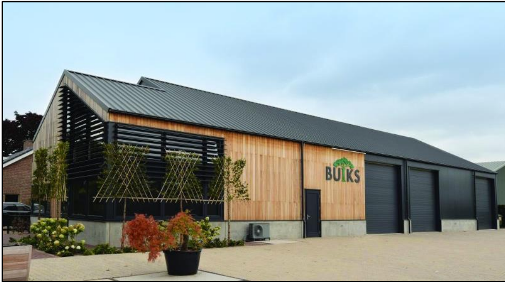
Afbeelding 9: Sfeerbeeld verbouw Loods
