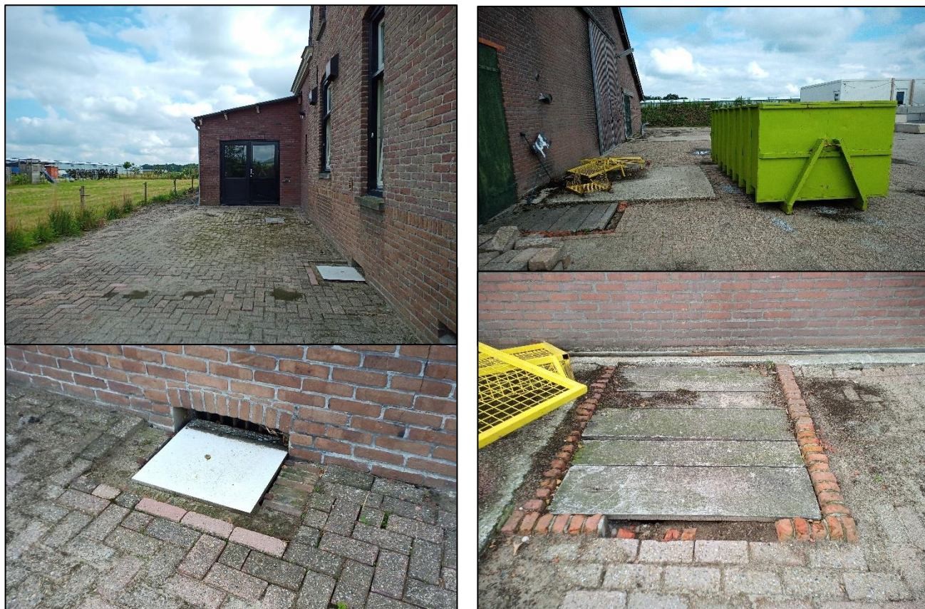
De kelder onder het woonhuis (links) en mestkelders onder de aangrenzende schuur (rechts).
