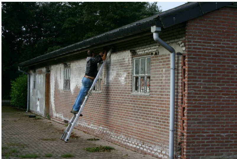
Figuur 4.2.3. De zuidoostzijde van de koeienstal werd volledig geïnspecteerd met behulp van een boomcamera.
