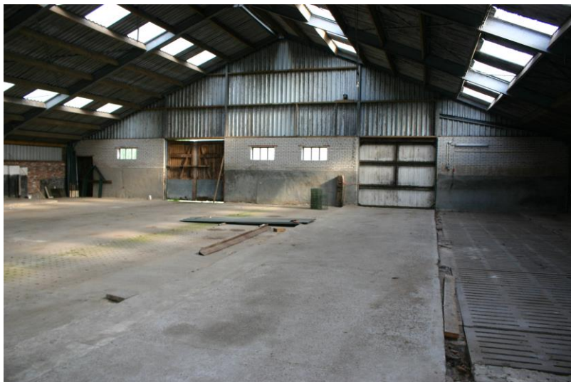
Figuur 4.2.4. Boven een hoogte van 3 meter zijn de wanden en het dak van de koeienstal vrijwel geheel enkelwandig.
