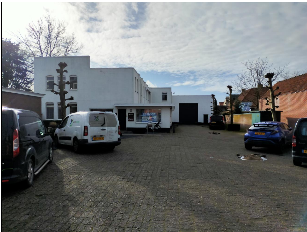
Figuur 7: Zicht op het plangebied gezien in zuidelijke richting (foto februari 2020).
