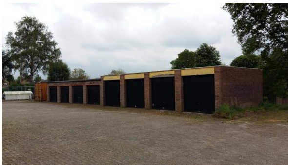
Garageboxen op het achterterrein
