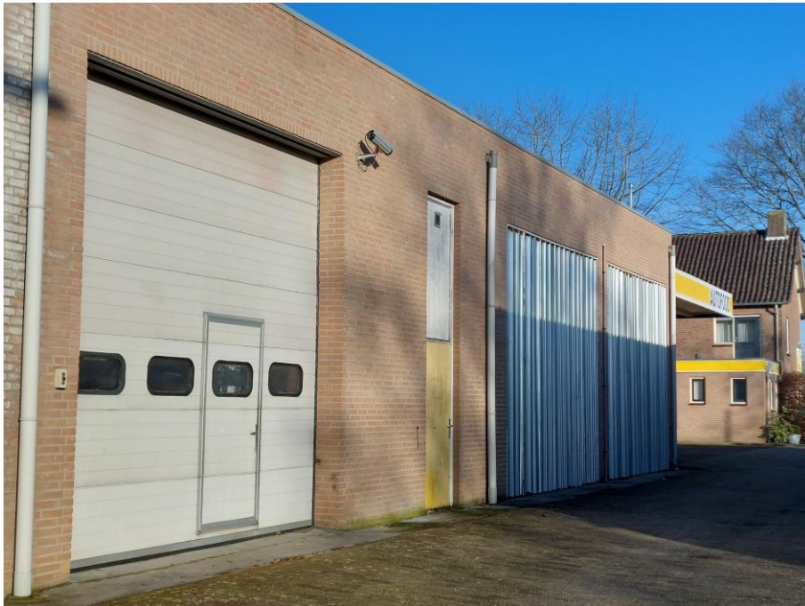
Afbeelding 7: in de muren bevinden zich geen open stootvoegen, die vleermuizen toegang bieden tot de spouwmuur
