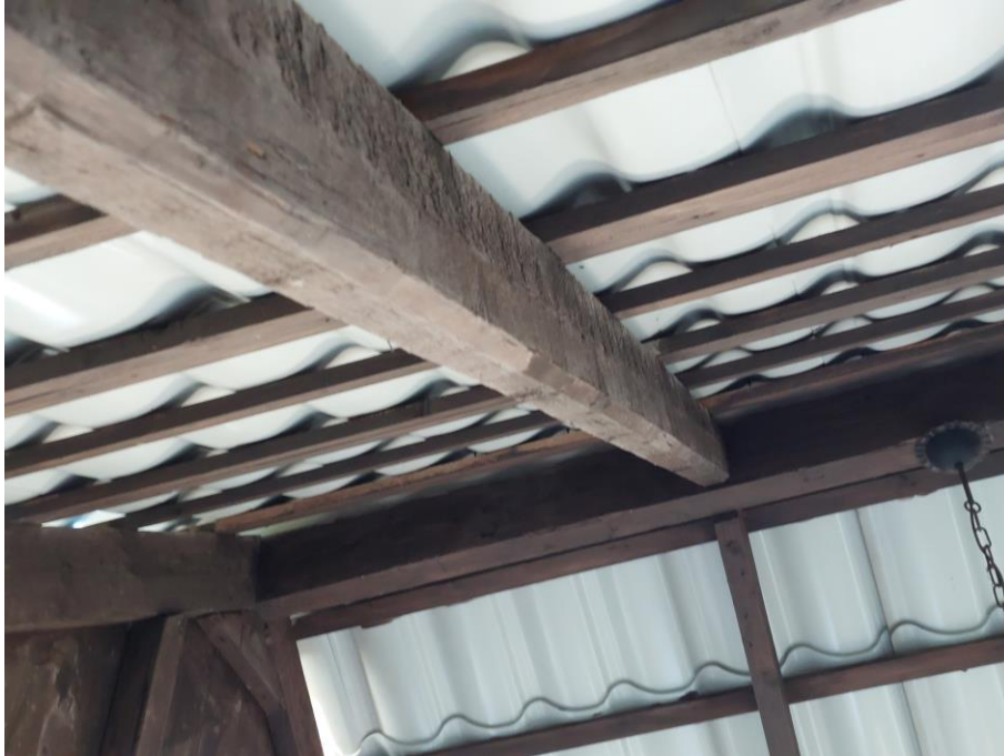
Afbeelding 6: veel van de gebouwen beschikken over een enkelwandig dak, opgebouwd met golfplaten
