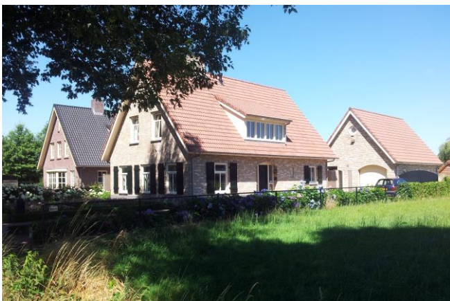
Woningen aan de westzijde van het plangebied
