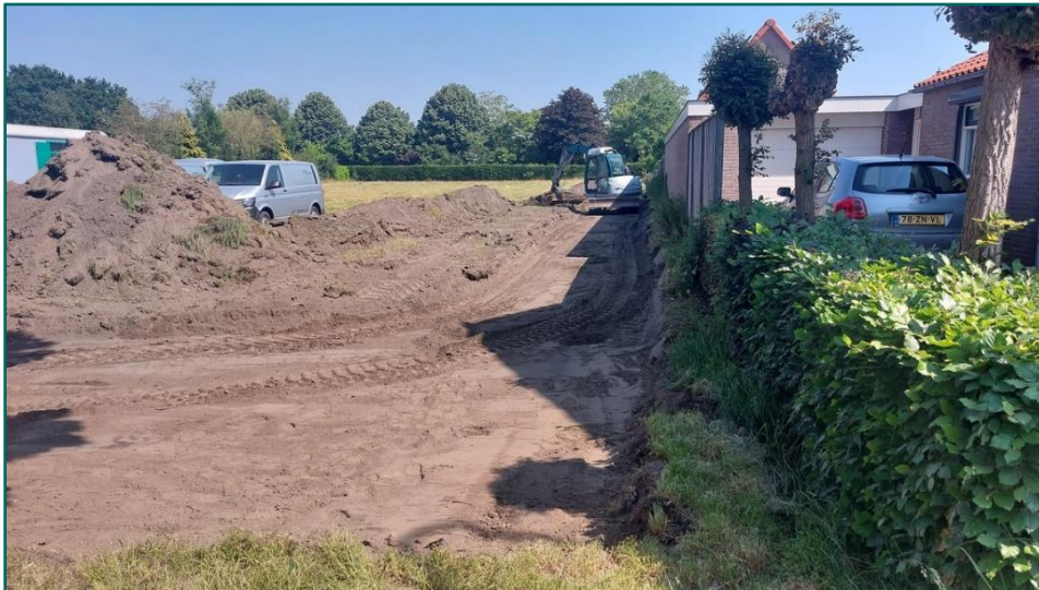
Figuur 3: Laagsgewijs afgraven met behulp van een kraan en actieve detector VMH-4.
