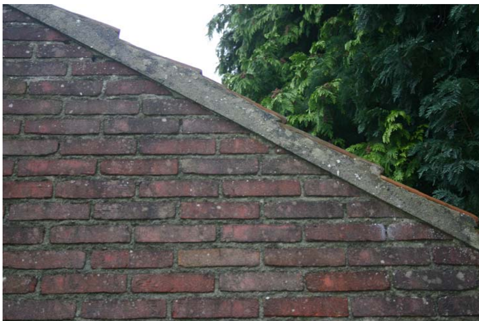
Figuur 3. De gevelpannen zijn in de cement gelegd.
