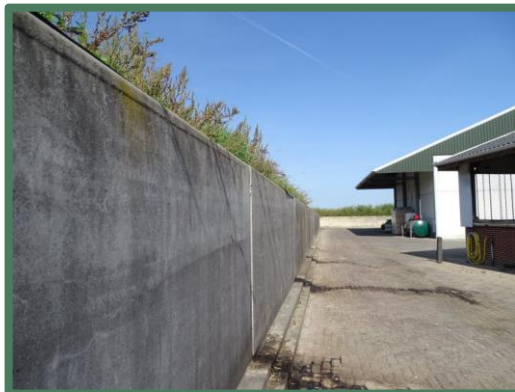
Sleufsilo gelgen in het westen
