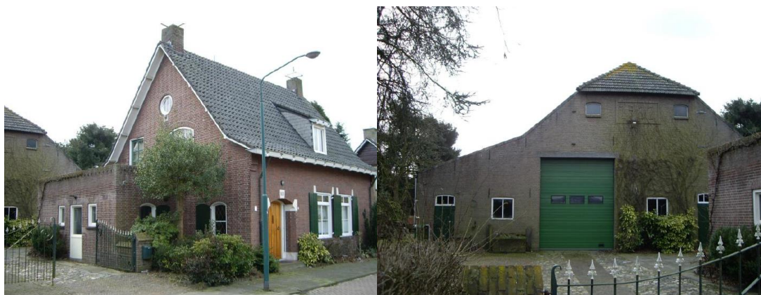
Figuur 7 Molenstraat 35/33 woonhuis (links) en schuur (rechts)
