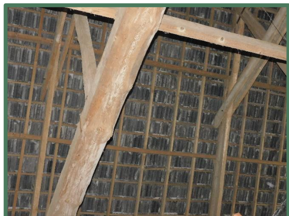
Onderzijde dak schuur nummer 35
