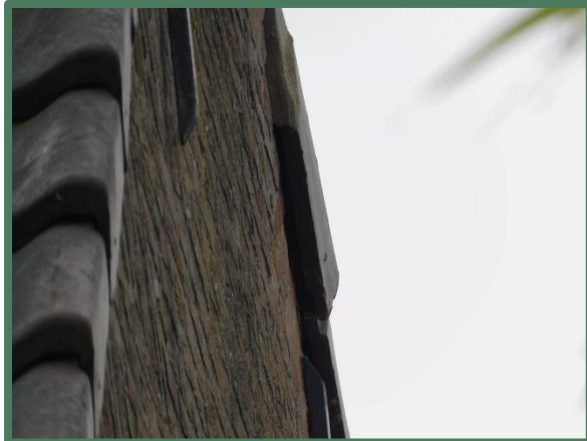
Ruimte onder de kopgevelpannen
