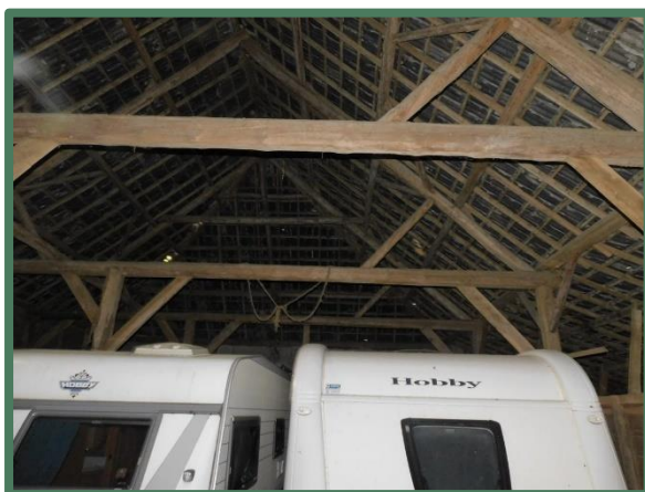
Onderzijde dak loods Molenstraat 31
