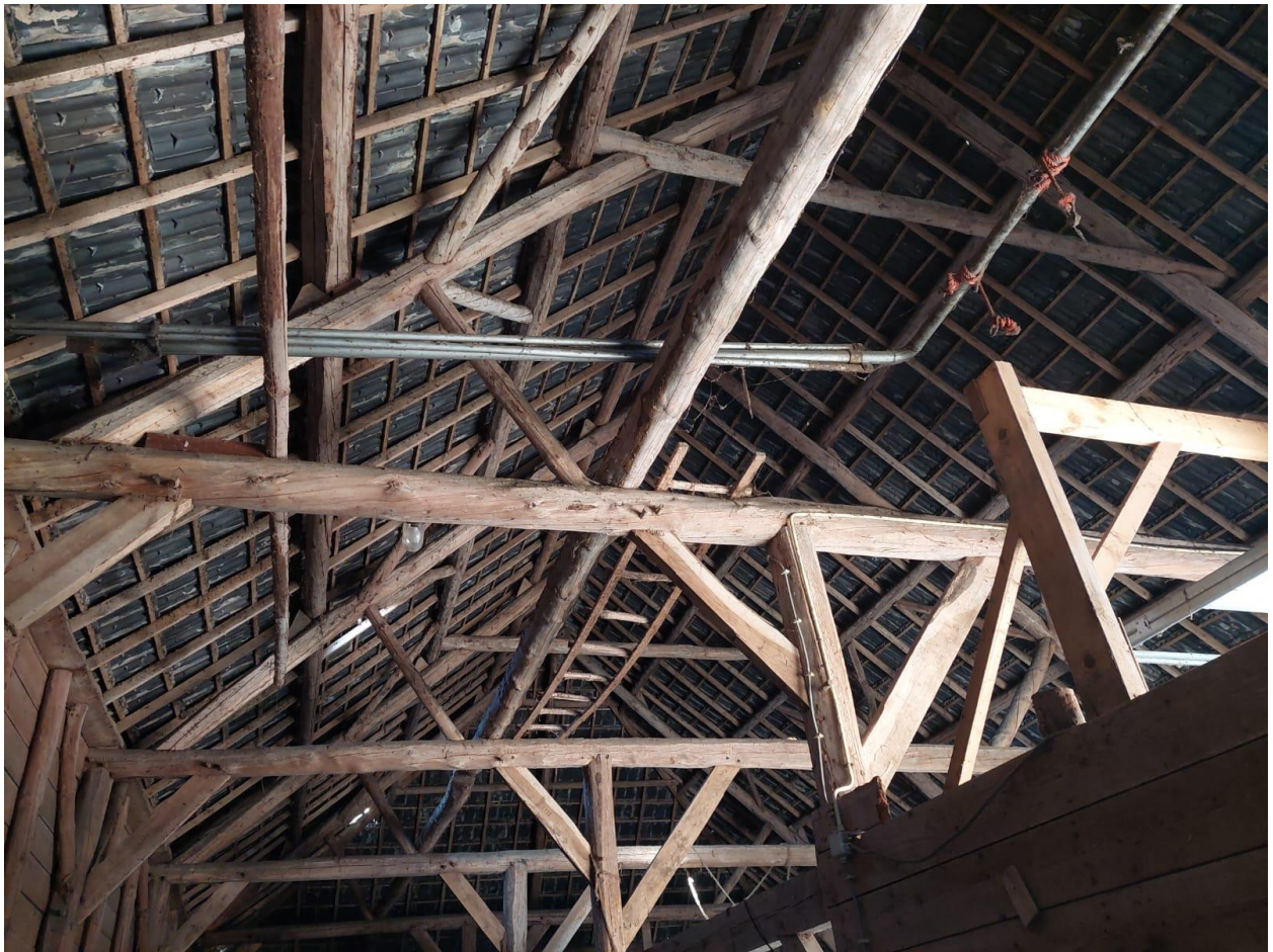
Figuur 40: Binnenzijde van de schuur.
