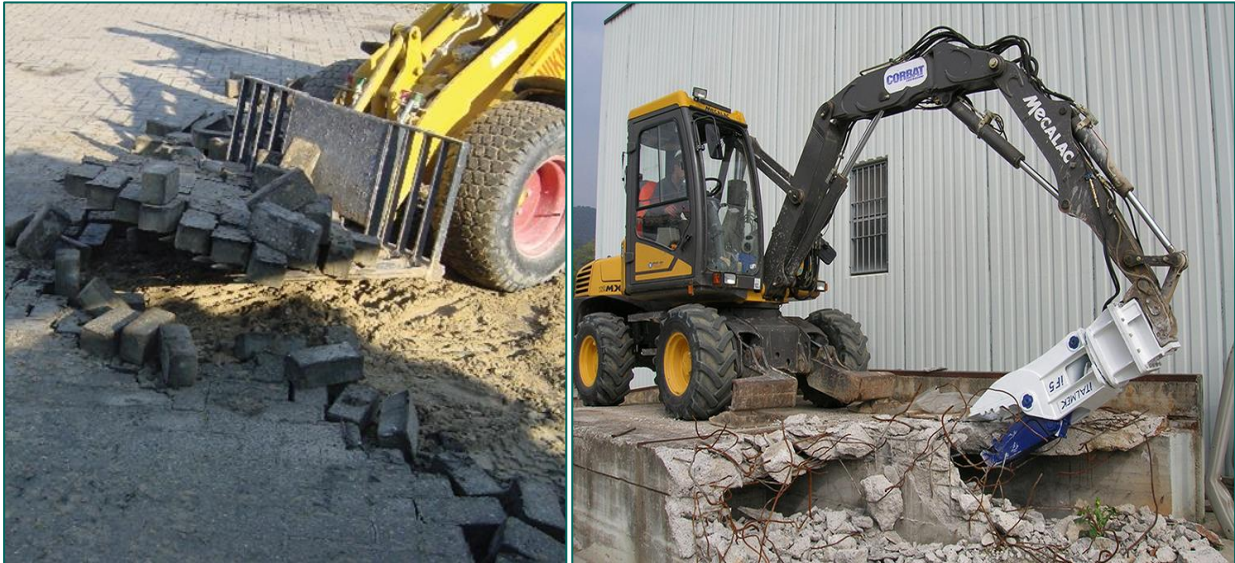
Figuur 22: Een stenenriek (ook wel tegelriek genoemd) wordt gebruikt om klinkers te verwijderen (links) en trillingvrij slopen middels betonschaar (rechts).
