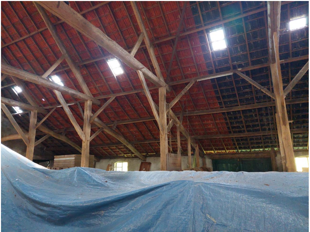
Figuur 52: Binnenaanzicht van de schuur.
