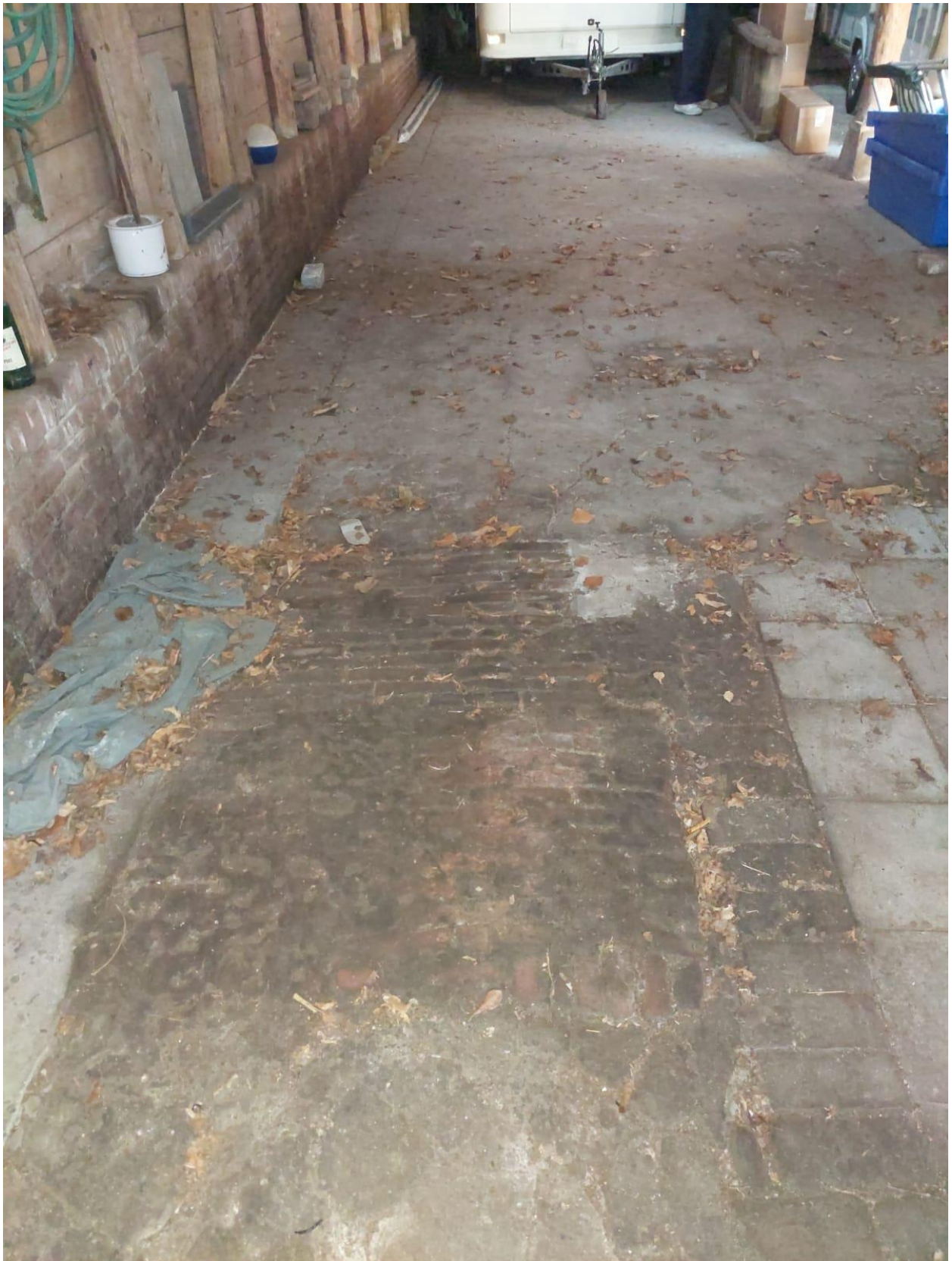
Figuur 41: Vloer binnen in de schuur, deze bestaat uit een mix van beton en op enkele delen klinker.
