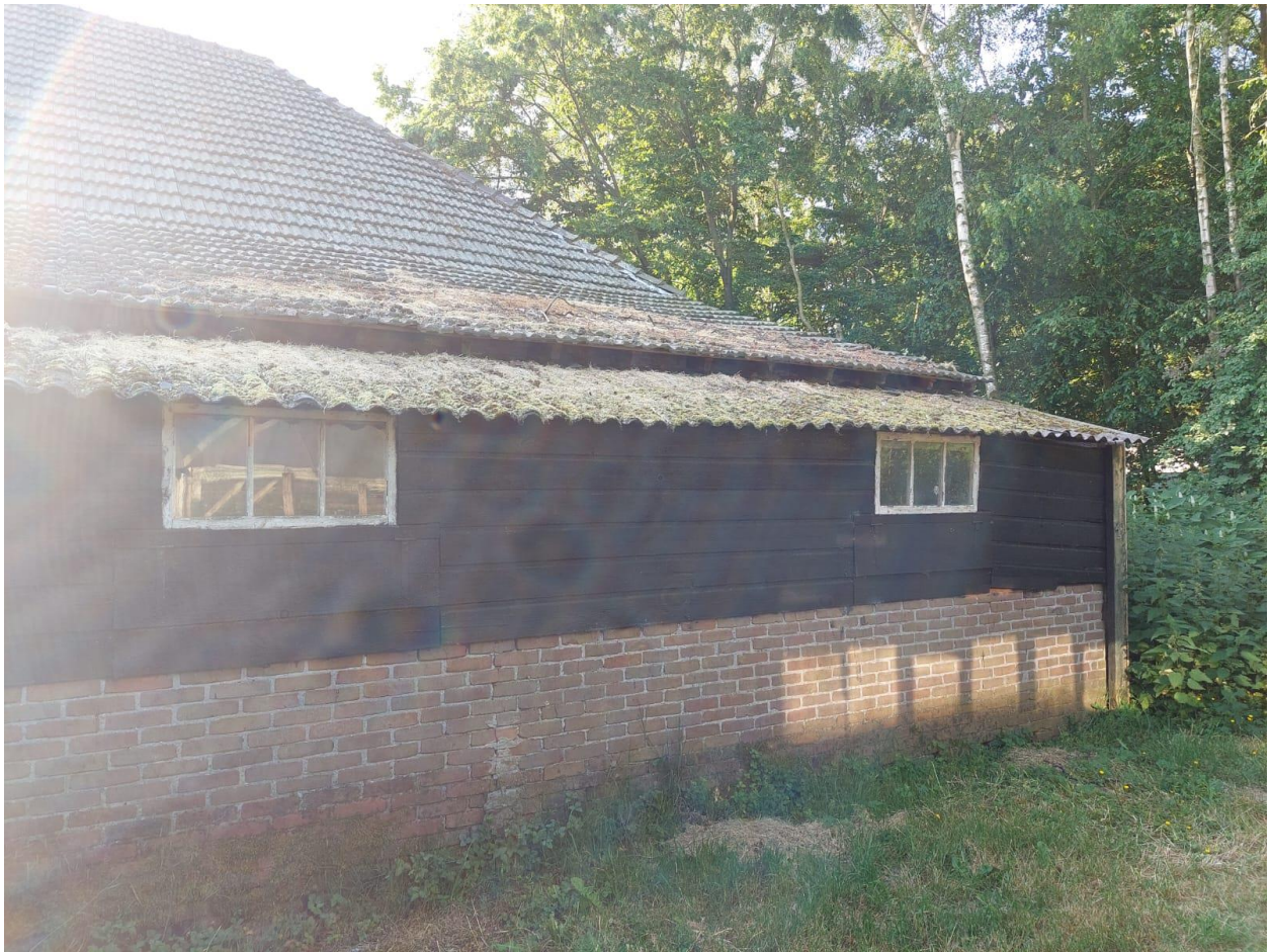
Figuur 39: Achterzijde van de schuur. In de hoek is het (gras) niet verhard. De daken zijn van asbest.
