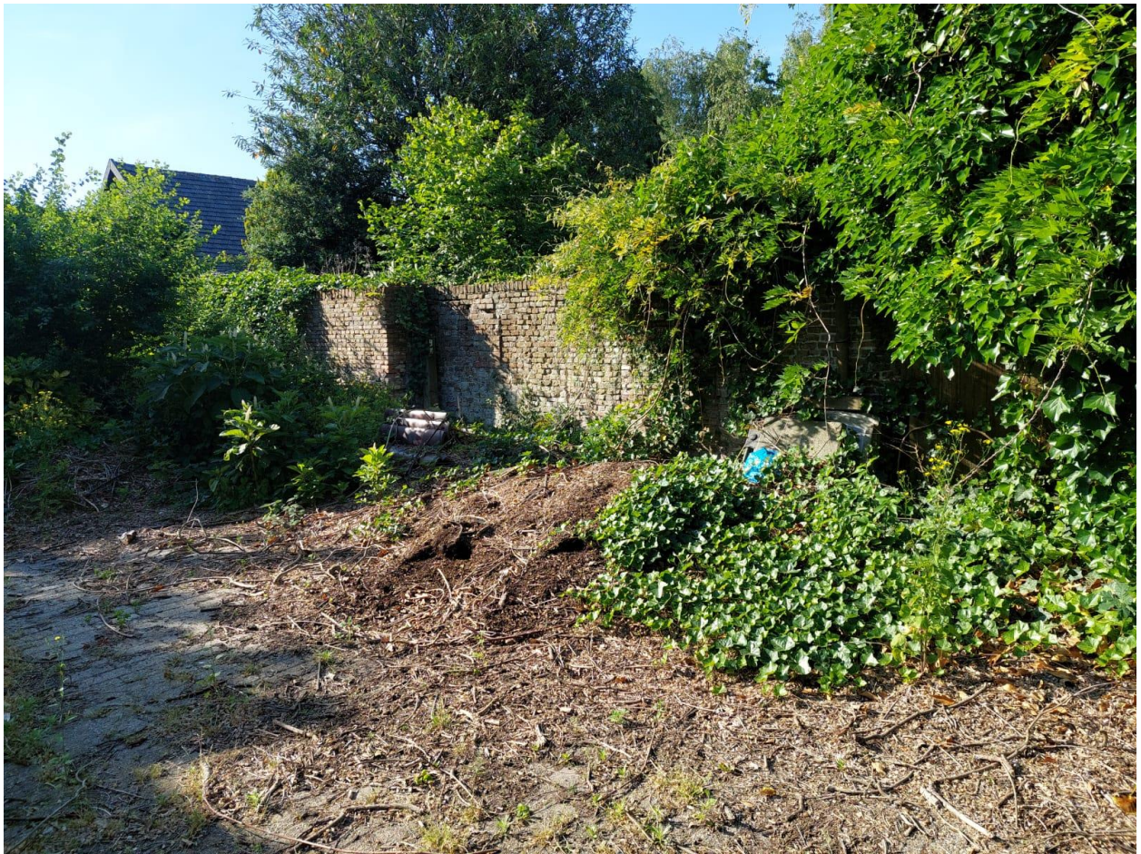
Figuur 47: De muur betreft de oude muur van de gesloopte woning.
