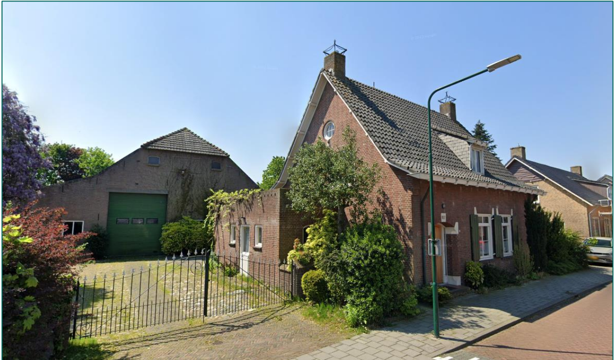
Figuur 12: Huidige situatie van de woning en schuur behorende bij Molenstraat nr. 35. Kenmerkend is dat de schoorsteendecoratie nog aanwezig is. De aangebouwde serre is aan het huis zichtbaar.
