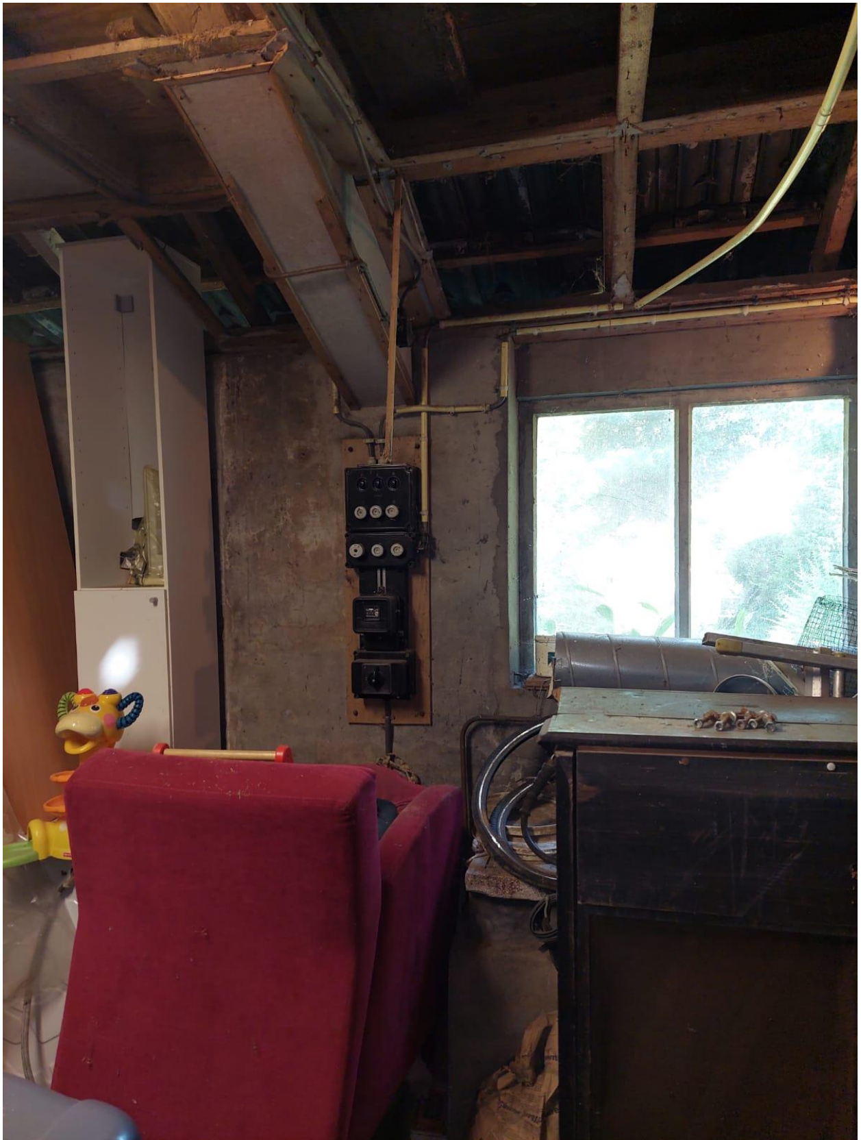
Figuur 54: Stoppenkast in schuur behorende bij woning nummer 45. Eigenaar heeft aangegeven dat de elektra naorlogs is. Onbekend is of de waterleiding(en) vooroorlogs zijn. Deze ruimte betrof de oude garage.
