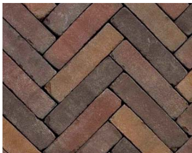
Straatbakstenen in keperverband
