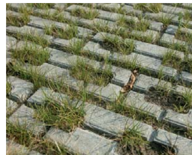
Open, grasklinkers van beton
