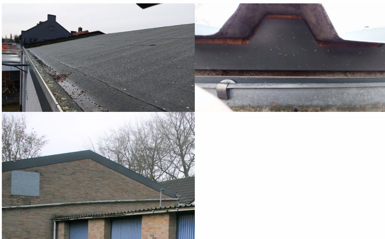
Figuur 4.4.4. De werkplaats (l) bevat opgemetselde kopgevels en een bitumen dak dat aansluit op de gevels. Bij het dak van het magazijn (r) zijn de openingen onder de metalen damwandplaten geheel afgedicht en de kopgevel bevat boeiboorden (lo).
