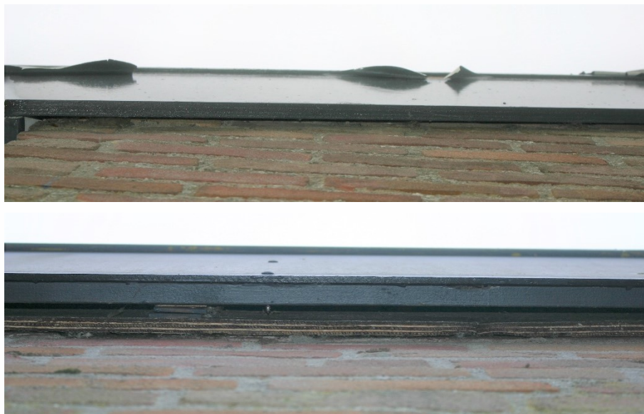
Figuur 4.4.5. De noordelijke kopgevels van het magazijn (b) en de showroom (o) bevatten een boeiboord dat kiert met de gevels waardoor vleermuizen hier achter kunnen verblijven.
