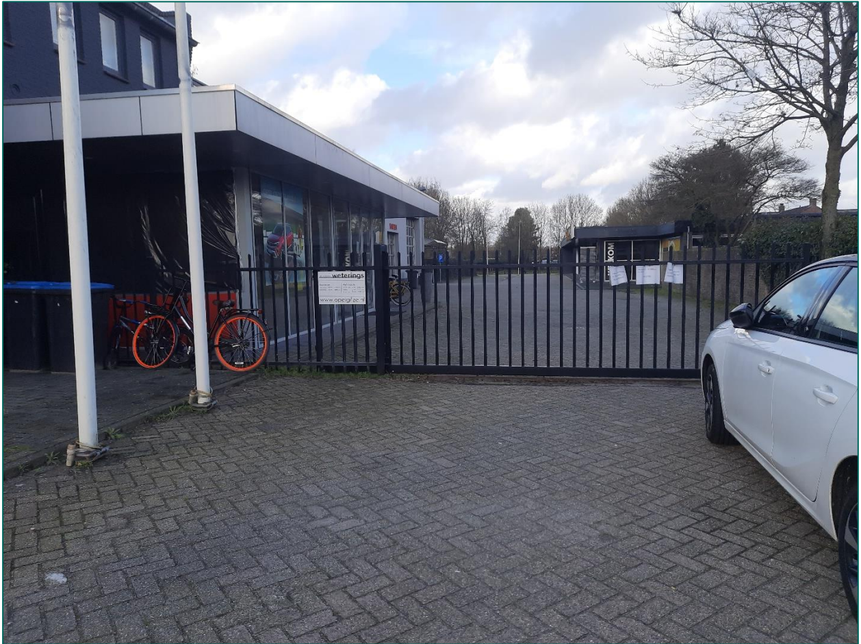
Figuur 56. Foto genomen aan de zuidzijde van de projectlocatie met het zicht op het noorden. Op de foto is de garage en de toegangspoort zichtbaar.
