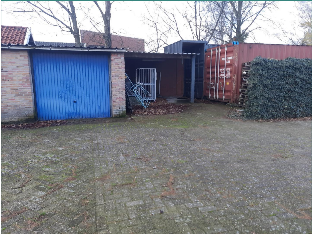
Figuur 51. Foto van de garageboxen en de naastgelegen opslagcontainers.
