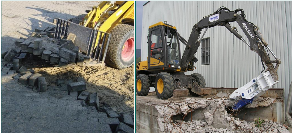
Figuur 32. Een stenenriek (ook wel tegelriek genoemd) wordt gebruikt om klinkers te verwijderen (links) en trillingvrij slopen middels betonschaar (rechts).
