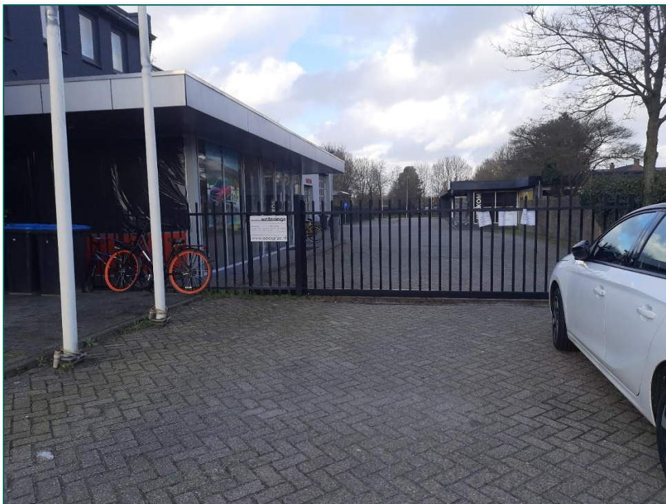
Figuur 14. Foto genomen aan de zuidzijde van de projectlocatie met het zicht op het noorden. Op de foto is de garage en de toegangspoort zichtbaar.
