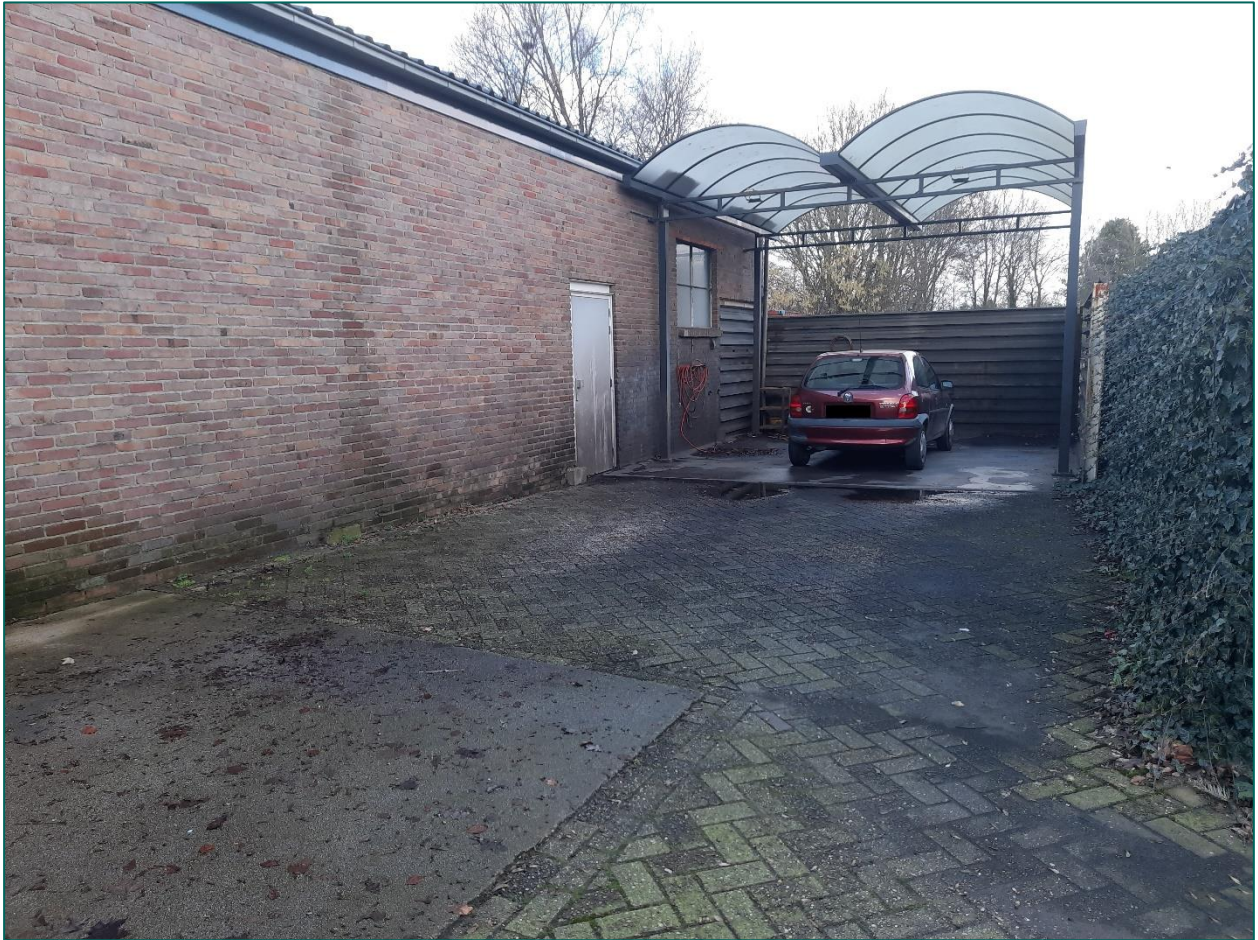
Figuur 54. Foto genomen midden in de projectlocatie met het zicht op noordwesten. Op de foto is de overkapping en de garage zichtbaar.
