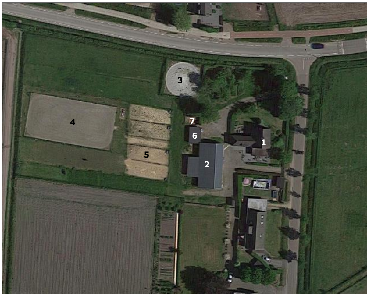
Afbeelding 3: Luchtfoto bestaande situatie
