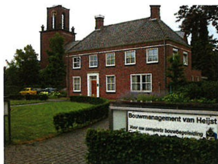
Foto 4: Kantoor- en woonpand (Rijksweg 24)
