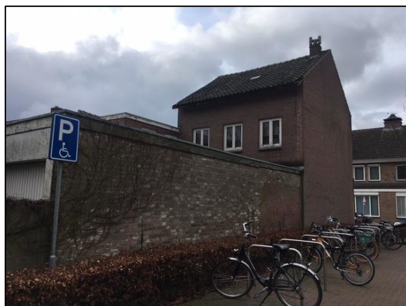
Afbeelding 4: Te slopen gebouw vanuit Patronaat
