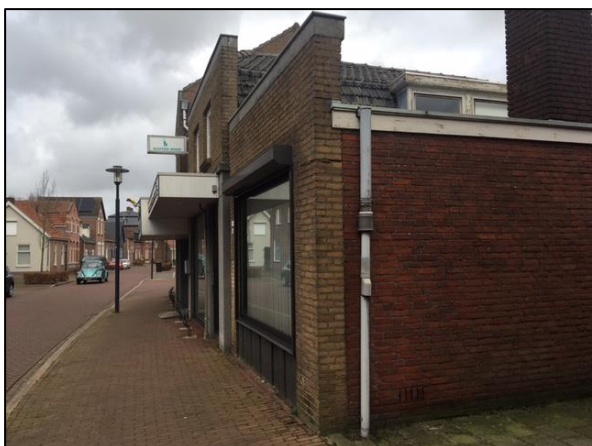
Afbeelding 3: Te slopen gebouw vanuit Kerstraat
