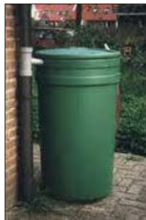
Afbeelding 8: Bijplaatsing regenton in regenafvoerpijp
