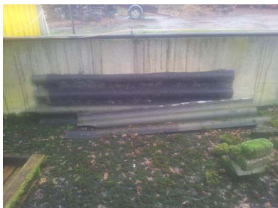
Afbeelding 3: asbestverdachte golfplaten betonnen verharding
