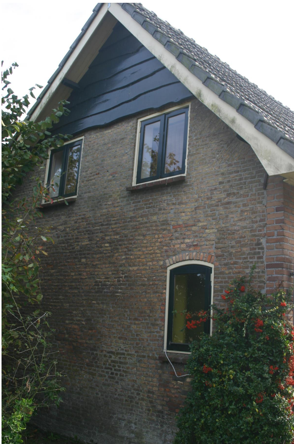
Figuur 4.4.1. Gevelbetimmering aan de noordzijde van de woning.
