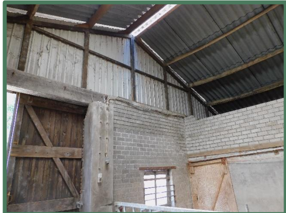
Binnenzijde voorgevel stal
