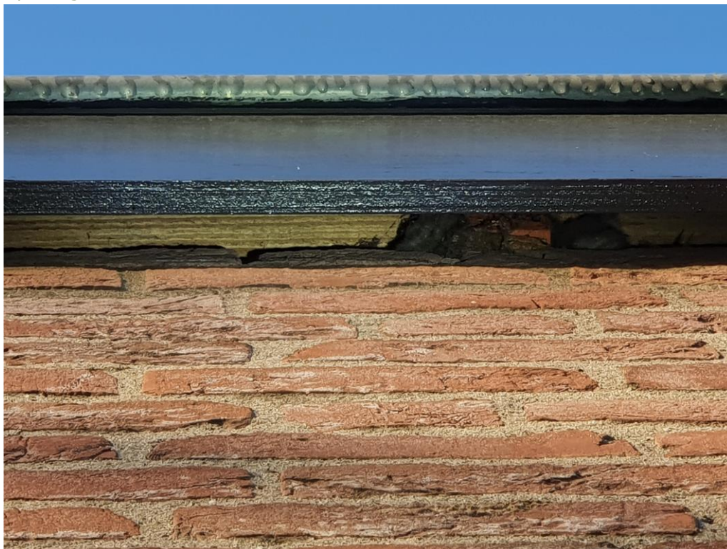
Opening tussen metselmuur en boeiborden:
