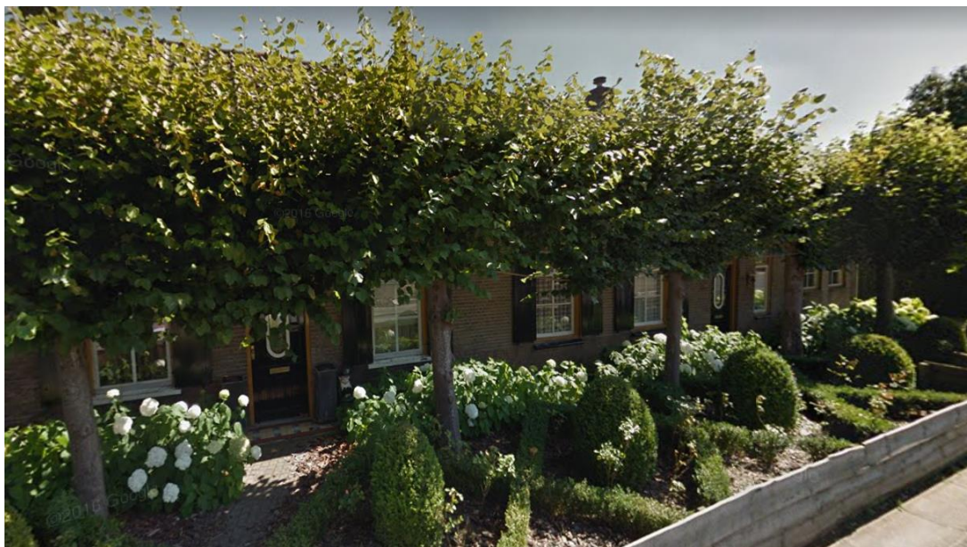
Figuur 4 Langgevelboerderij Hengelstraat 50-52
