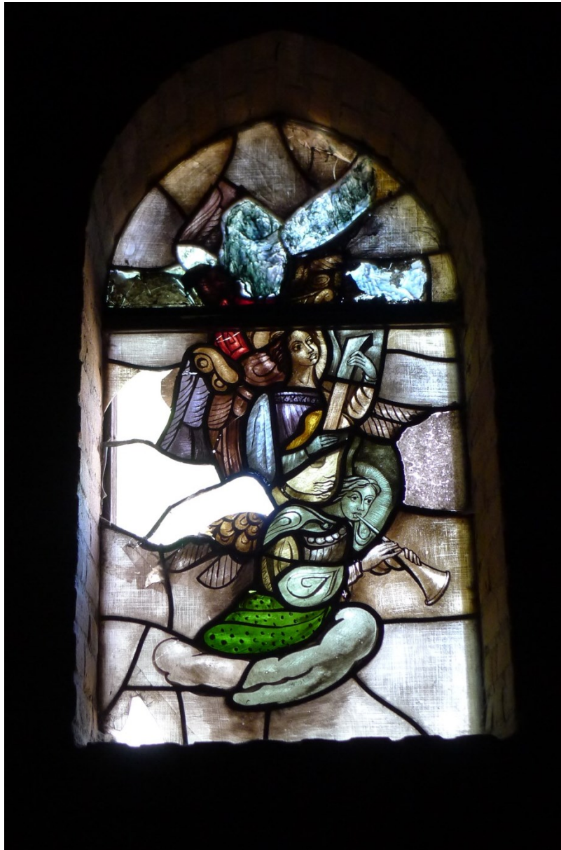
Voorbeeld van een van de glas-in-lood ramen die gebroken is
