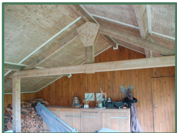
Afdak oude kippenschuur
