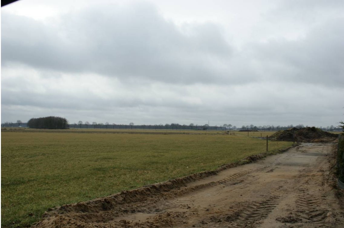
Figuur 3.5. Beeld van het landschap ten zuiden van de Broekstraat. De leiding komt langs de ontgraving en rechts van het beplantingselement.
