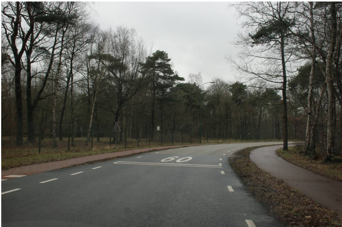
Figuur 3.14. Beeld van het tracé langs de Heideweg globaal ter plaatse van de gestuurde boring (wel EHS, aanleg in een versmalde werkstrook van 10 meter). De struiken en mogelijk enkele bomen worden gerooid.
