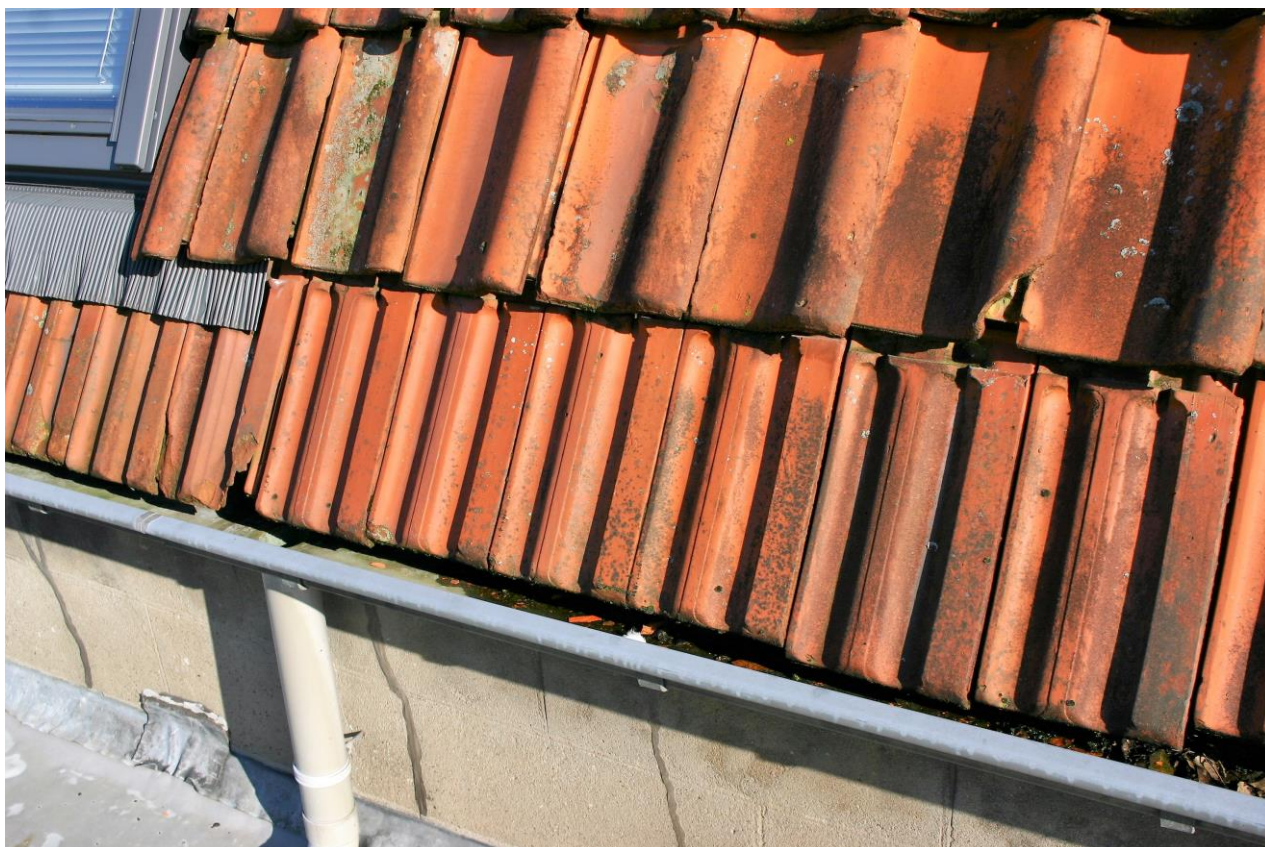
Figuur 4.2.3. De goten zijn direct onder de dakpannen bevestigd, zodat huismussen en vleermuizen de ruimte onder de dakpannen niet kunnen bereiken.
